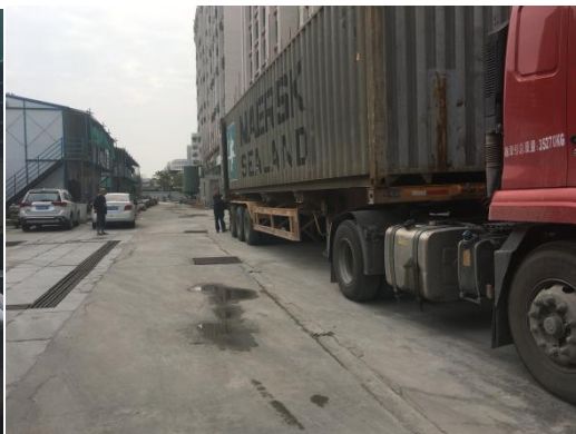
照片 2 施工道路
