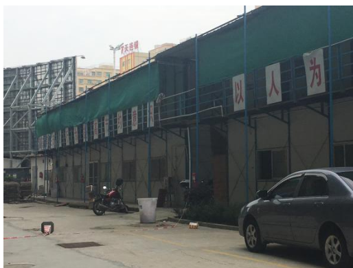
照片 1 施工生产生活区
